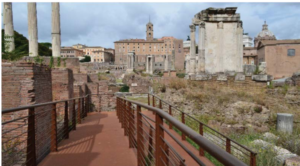
La nuova rampa in corten di collegamento tra la Casa delle Vestali e il Tempio di Vesta nel Foro Romano. La struttura aerea consente di osservare i resti archeologici sottostanti.
