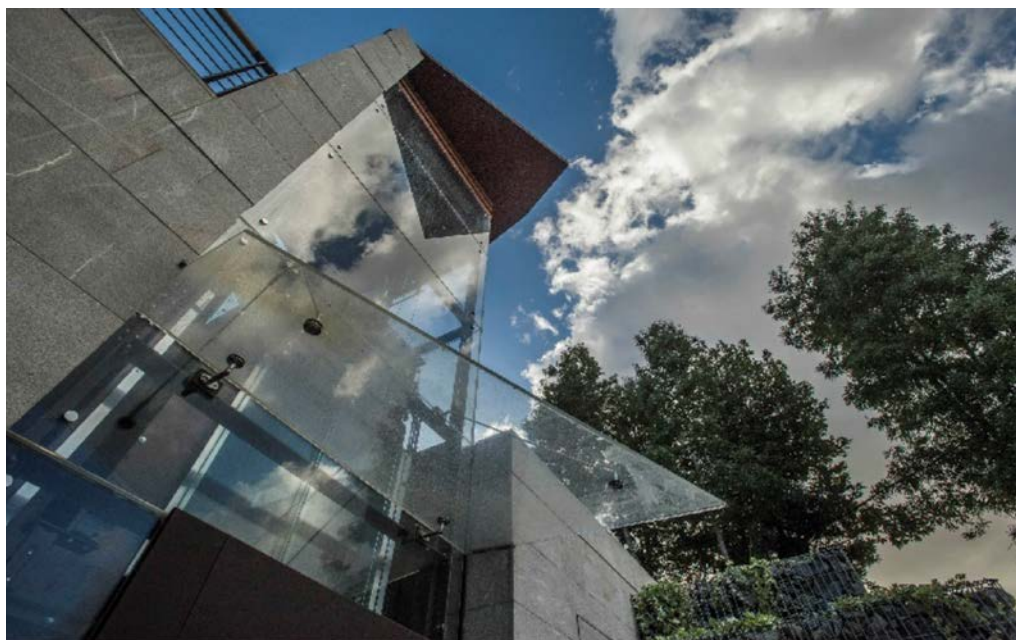
Il nuovo ascensore inaugurato nel 2013 all'ingresso dei Fori da Largo della Salara Vecchia. La struttura, semplicemente appoggiata, è totalmente reversibile.
