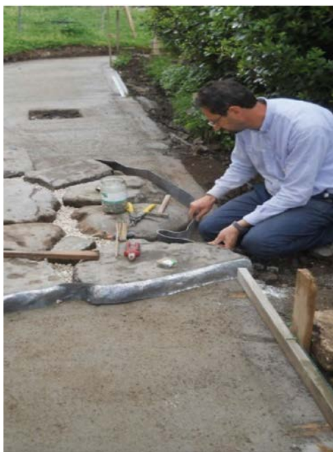
Fase di restauro del basolato incluso nel percorso accessibile mediante bordatura con fascette di piombo e stuccatura degli interstizi per livellare il piano di calpestio.
