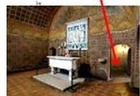
Si è scelta questa posizione perché esisteva già il piccolo vano con una scaletta lignea di collegamento al primo piano, di nessun valore storico e non più utilizzata, che poteva essere demolita sfruttandone il foro di passaggio nella volta già praticato in passato
